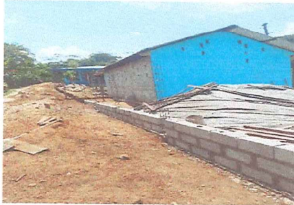
Foto 7: INICIO MURO PERIMETRAL
