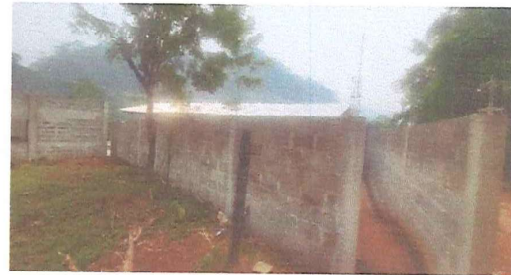
Foto 8: FINALIZACION DEL MURO FOTO DE AMBOS LADOS
